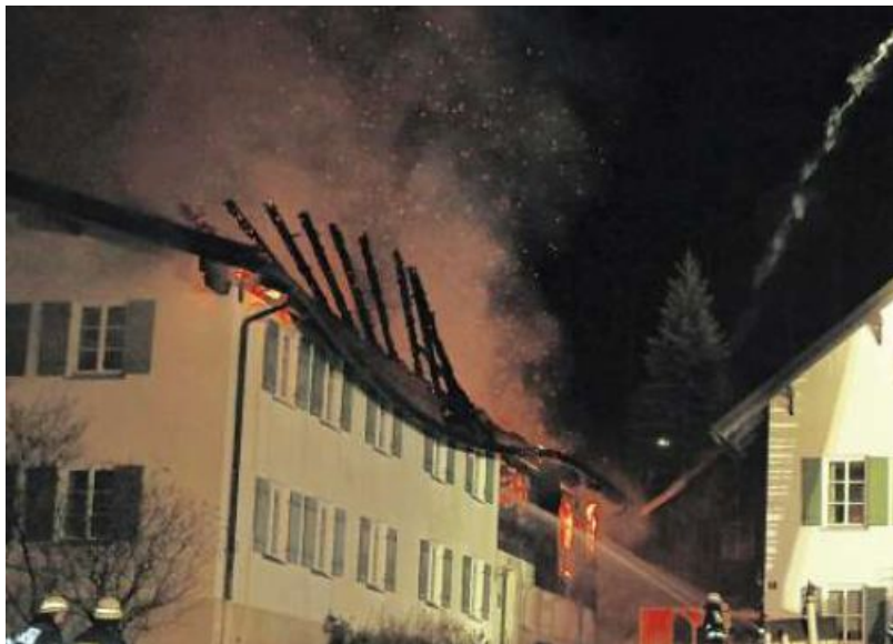
Am Verwaltungsgebäude (vorne) wurde vor allem der Dachstuhl zerstört, der Stadel brannte völlig aus. Foto: Daniel Dollinger
